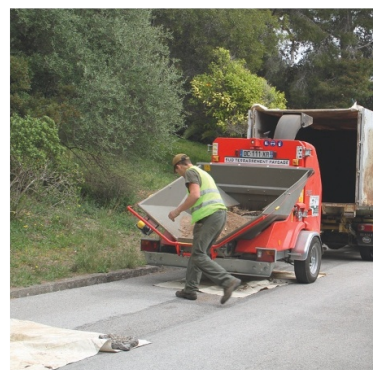
Nettoyage soigneux du chantier.
